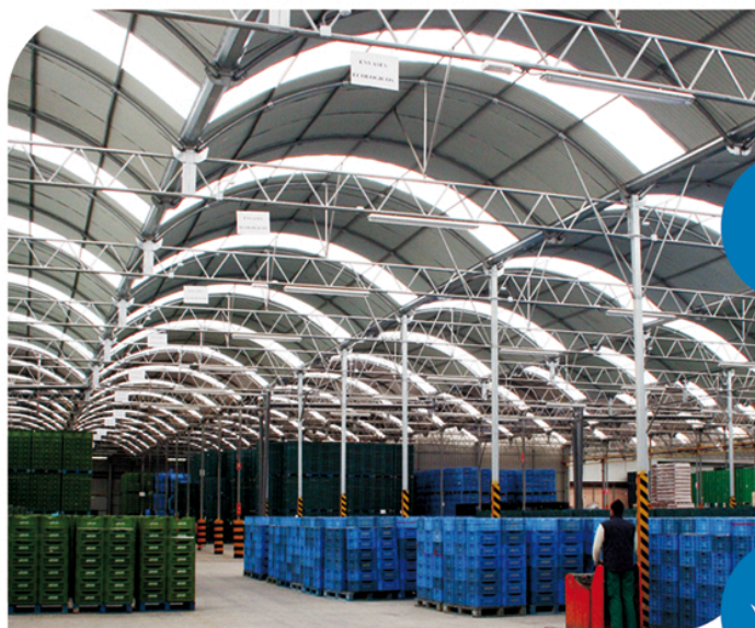
Nave de Almacenaje
